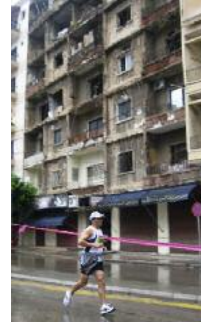
► Zerschossene Häuserfront an der Strecke
